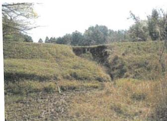
新池は寛政年間に築造され、人夫一万数千人を要した当村第二の池である。灌漑面積も広く、東山、中溝、喜録寺、別久、上段、流田及び上岩志に及んだ。而もこれでもまだ水不足に悩んだので、更に堤体を嵩上げして湛水量を多くしようとの議が起りその工事に着手したが、この時この工事が完成すれば池の奥の上楽田地が水没して耕作不能になるのでこの地の地主が反対し工事は半途にして中止された。この池の堤体が二段三段と段がついているのはこの中止の跡である。
